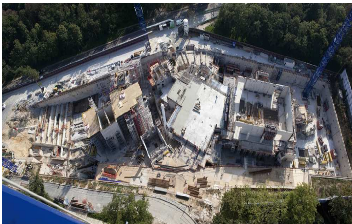
Chantier de la Fondation Louis Vuitton
